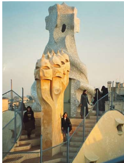
Figura 1.24 - Chaminés da Casa Batlló
