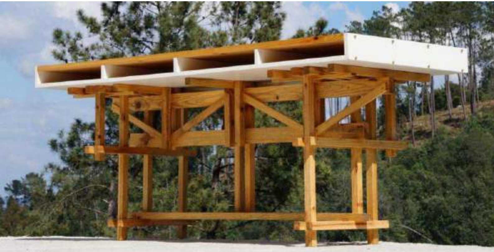
Fig. 25: Vista da mesa treliça e dos detalhes de encaixes de sua parte superior com diversas peças de pinho de assoalho.
